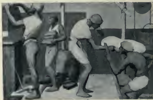
GALLAND. — LES MÉTIERS : MAÇON (galerie de la cour Sud).
